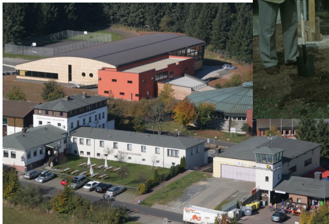
Der Neubau ist fertig
