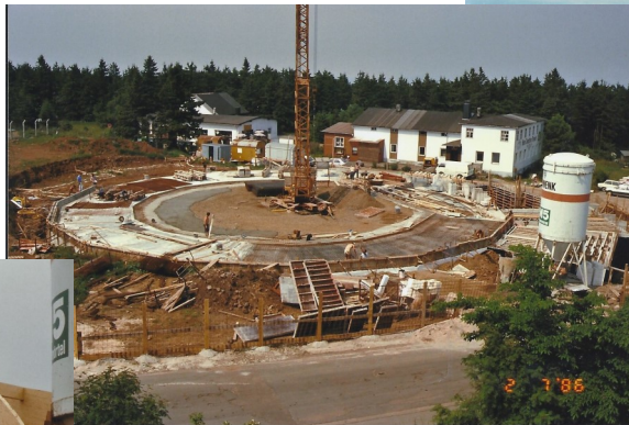
Keller und Fundament für den Rundbau 1986
