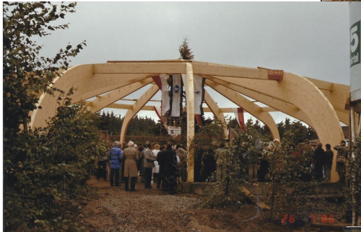
Richtfest für den Rundbau
