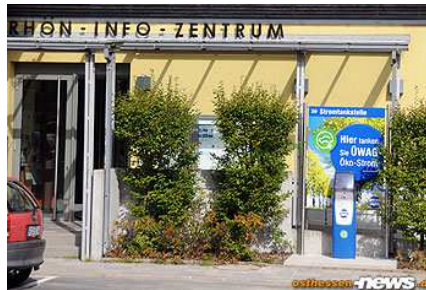
Stromtankstelle Infozentrum Waku
