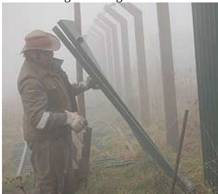
Ein Arbeitstrupp baut bei „Knofe“ den Zaun ab
