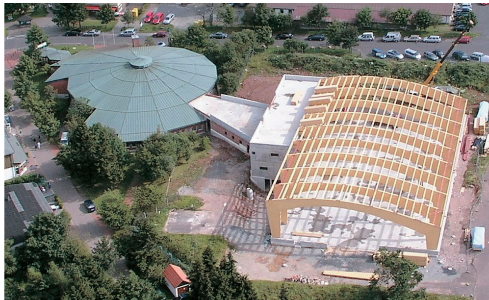
Inzwischen sind die Seitenwände hochgezogen und das Kupferdach gedeckt Foto: Assel
